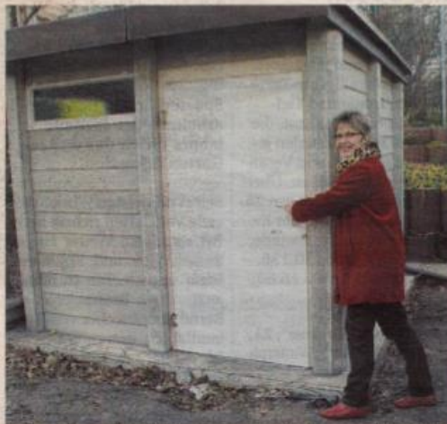
Sabine Karau hofft, dass das behindertengerechte Toilettenhaus im Mehrgenerationengarten bis zum Saisonbeginn im März fertiggestellt werden kann. Foto: Sylvia Baumeister
